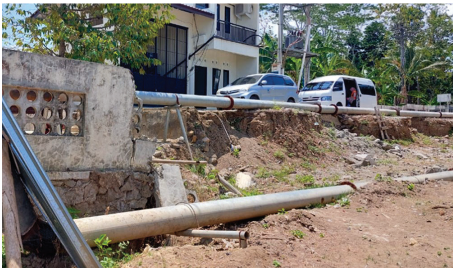
GAMBAR 10: MENINGGIKAN PIPA AIR UNTUK MENGURANGI RISIKO IKLIM
