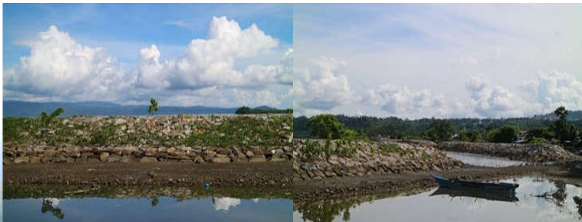
Pembangunan Tanggul Laut di Desa Guraping, Tidore Kepulauan, Maluku Utara
