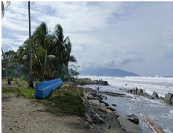
Kondisi Pesisir Pantai Skouw Mabo Terdampak Abrasi
