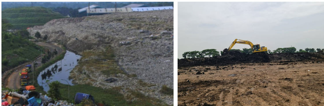
Gambar 3.25 Lokasi pembangunan Fasilitas RDF Kelurahan Rorotan, Kecamatan Cilincing, Jakarta Utara
