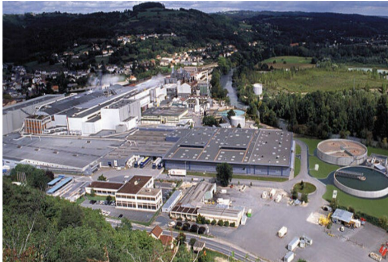
Gambar 4.7 Pembangunan RDF boiler di fasilitas Pabrik Kertas Condap Paper Mill, Prancis
