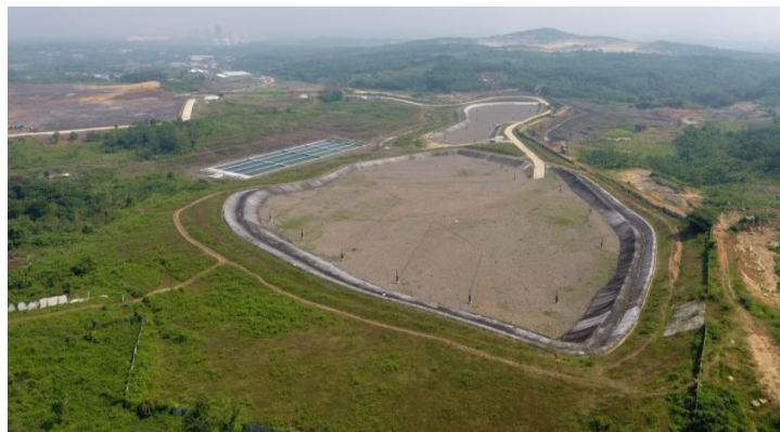
Gambar 3.24 Lokasi pembangunan fasilitas pengolahan sampah menjadi RDF di TPPAS Lulut Nambo
