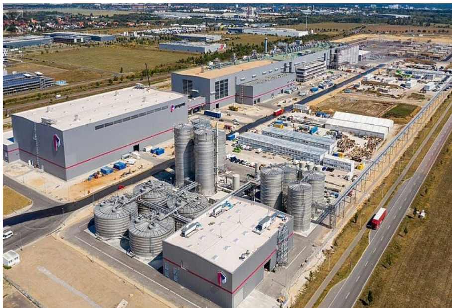
Gambar 4.6 Pembangunan RDF boiler di fasilitas pabrik kertas Sandersforf-Brehna, Jerman
